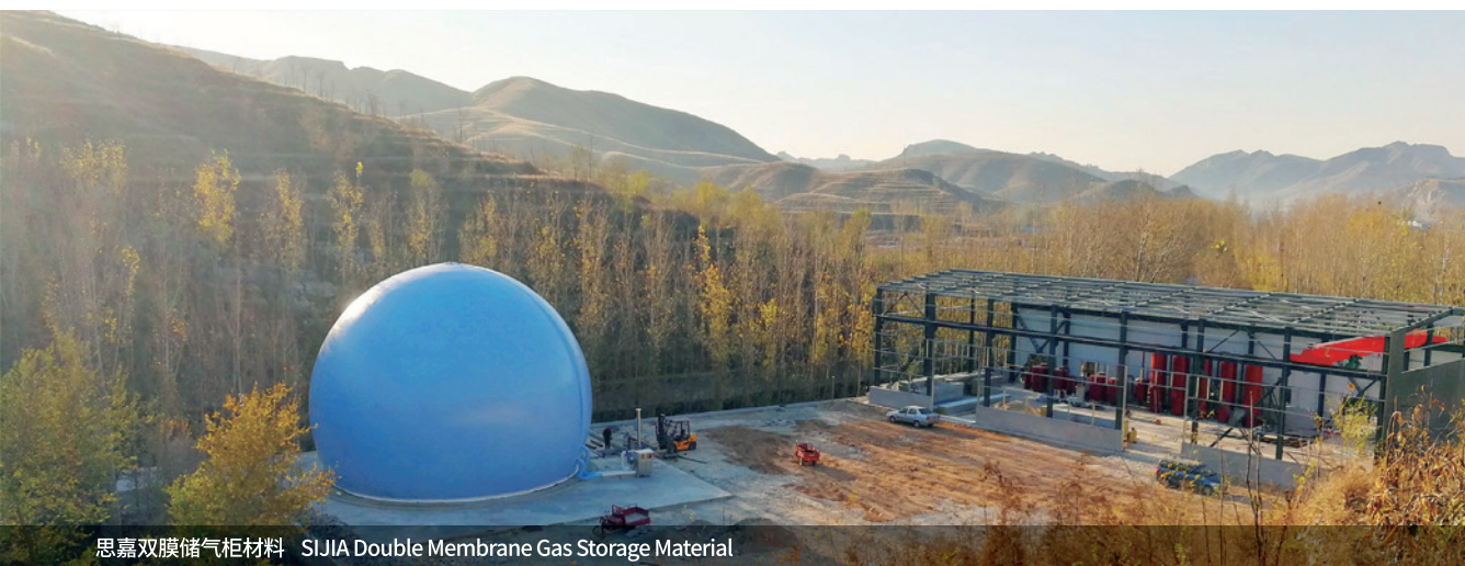
环保沼气生态能源项目 Environmental Biogas Eco Energy Project
